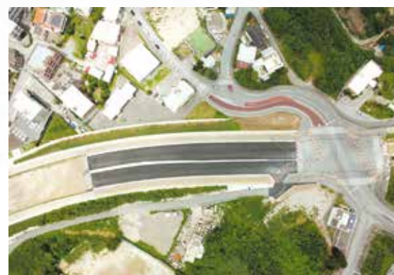
宜野湾北中城線道路改良工事(2017)
