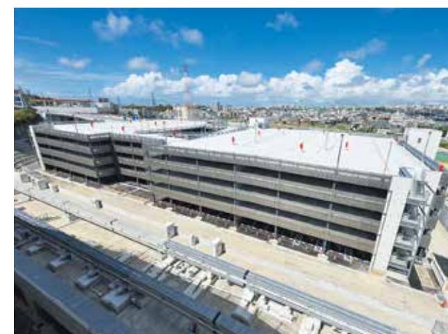
てだこ浦西駅パークアンドライド駐車場新築工事(浦添市)2019年
