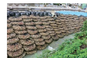
災害復旧工事
